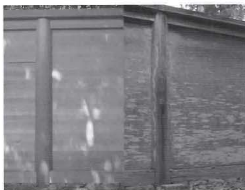
写真4 伊勢神宮の新旧の板垣 素木のヒノキ約20年の経年変化
