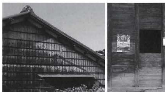
(左)写真1-1 築数年程度の杉板外壁の経年変化
