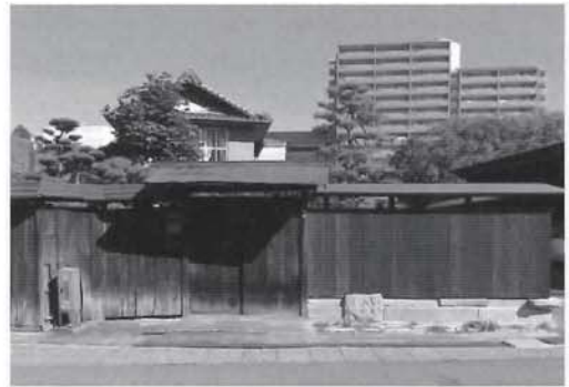
写真2 古色仕上げの例
