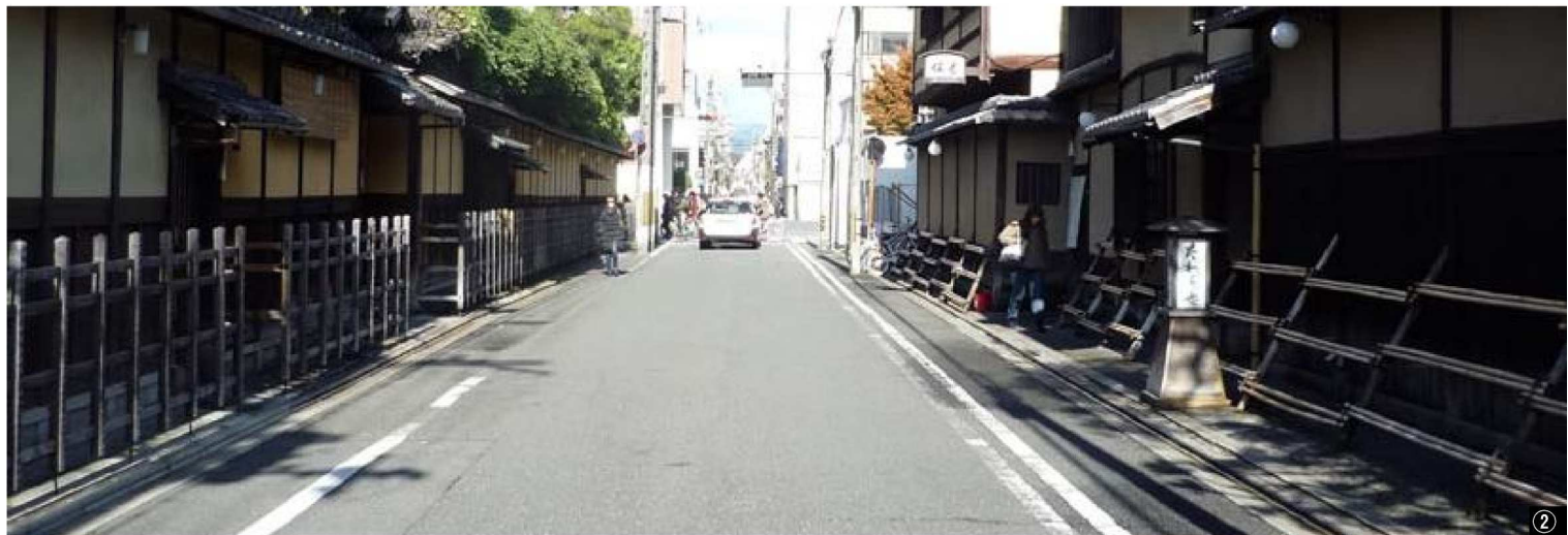
② 柵家と俵屋(つばどめ・駒寄の設置年代は不詳、中京区) 柵家の敷地を囲む塀の前に駒寄が、俵屋の前にはつばどめがはりめぐらされている。塀への接近・接触を阻止すること以外に機能らしいものは無い。人の進入を拒みつつ、同時に格式を高めるデザインでもある。
