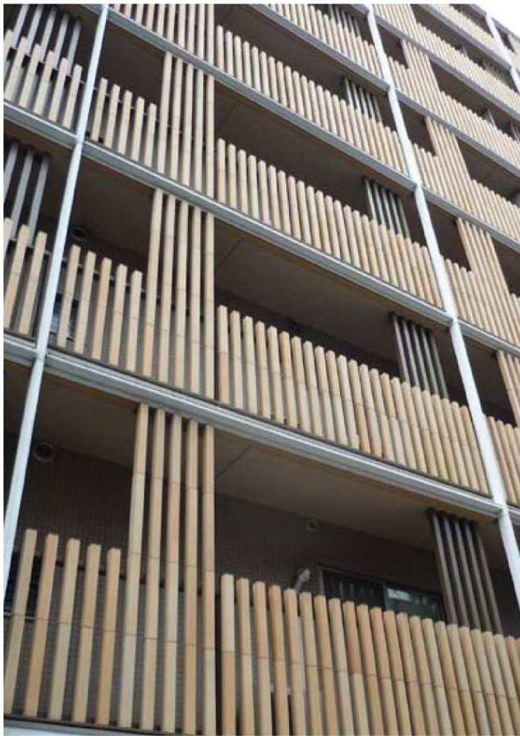
④グランブルー三条柳馬場(2002年・京都市中京区) 道路に面した外壁全面をセラミック製の格子で覆ったマンション。格子はバルコニーの手すりの機能も担っている。
