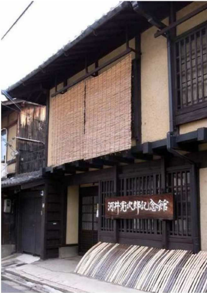
②河井寛次郎記念館(1937年・京都市東山区) 京都市中では珍しい出桁造により2階をセットオーバーさせた町家。突出した梁や出桁が、機能的にも景観的にも庇と同等以上の効果を発揮している。
